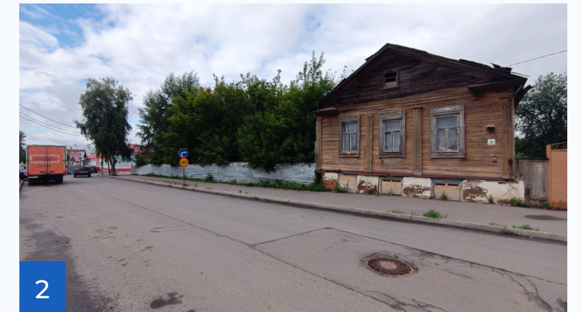
2 Строения со следами износа в границах участка
